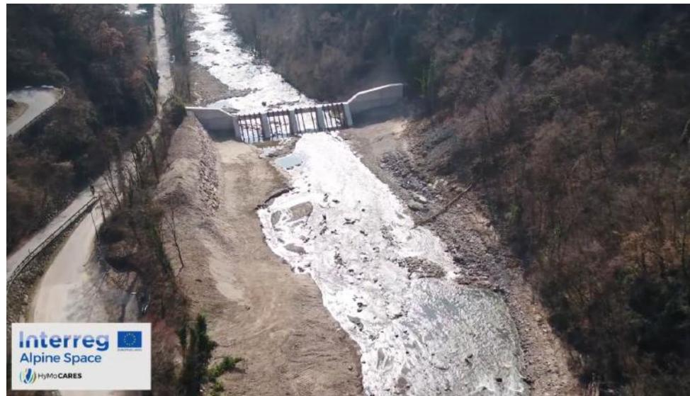
Torrente Talvera a monte della città di Bolzano - Rimozione di due briglie di trattenimento e realizzazione di una briglia filtrante
