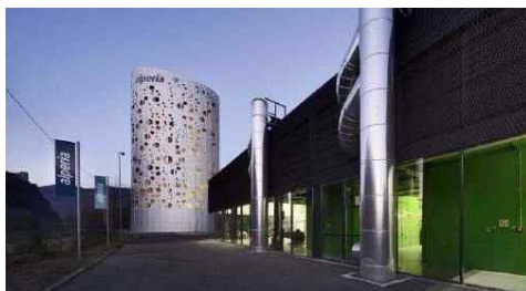
Centrale di teleriscaldamento Alperia, Quartiere Casanova
