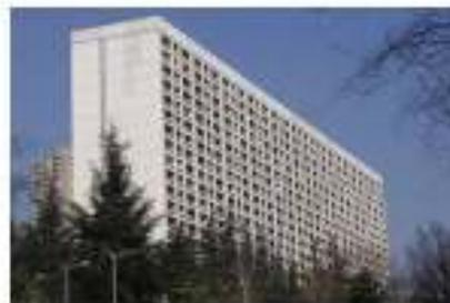
Conçu par Jean Dubuisson en 1967, l'immeuble des Érables est l'une des plus importantes barres de logements de La Duchère. Son principe constructif sur pilotis dégage au rez-de-chaussée une longue rue intérieure, et les logements traversants offrent des points de vue spectaculaire sur la vallée de la Saône.
